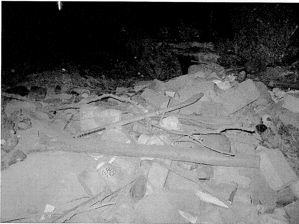
Kuva 4. Ryömintätilan alapohjassa orgaanista jätettä ym.
