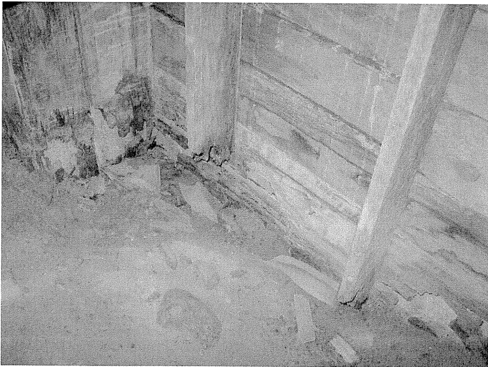
Kuva 6. Ryömintätilassa lahonneita muottilautoja.
