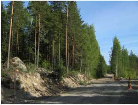
Uusi tielinja leikkaa moreenikumpua ja paljastaa karkearakeisen, lajittumattoman pohjamaan.
