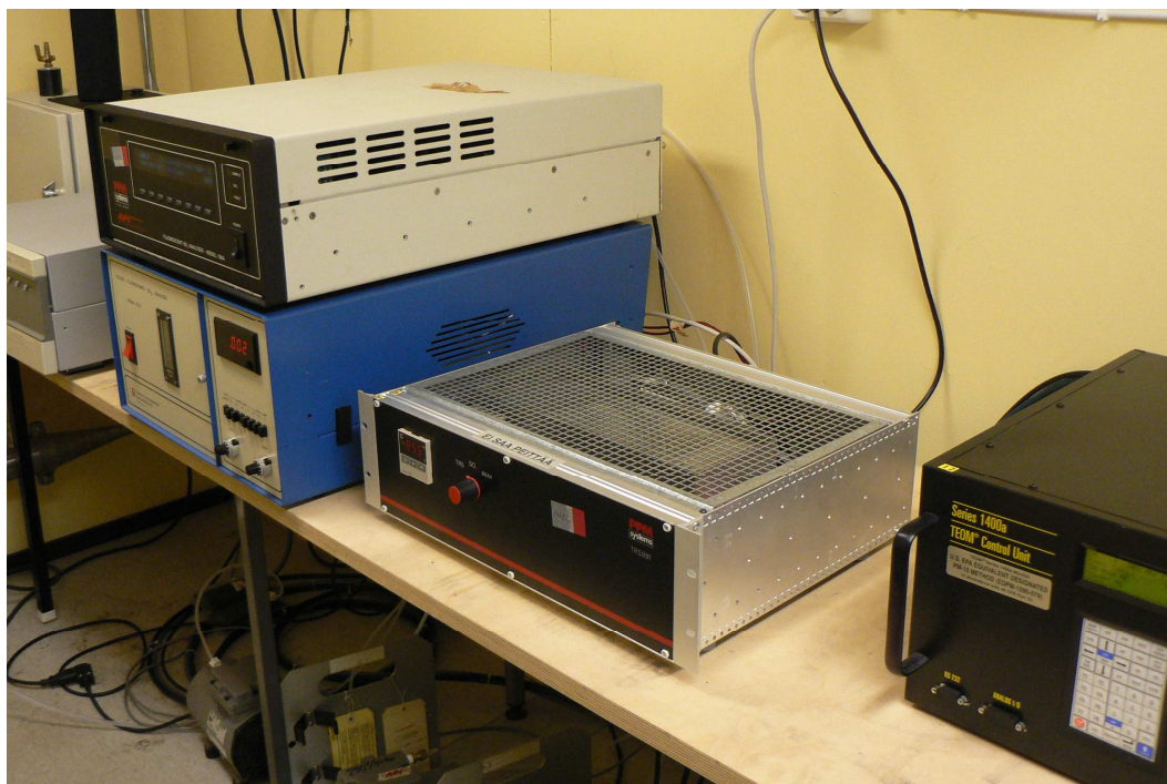
Kuva 2: Ilmanlaadun mittauslaitteet Hiskinmäellä.
