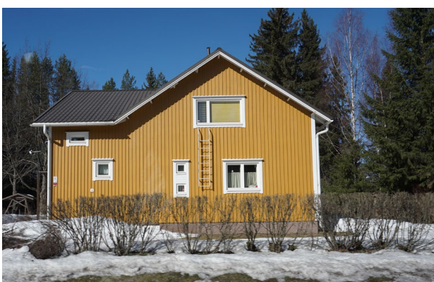
Kuvia. Tiesuunnitelmien ja kaavamutoksen myötä poistuvia asuinrakennuksia. (Äänekosken kaupunki & Google)
