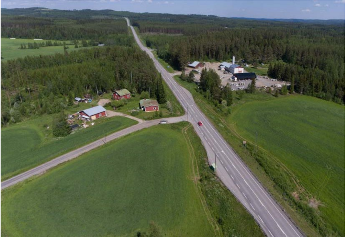
Kuva. Lantelantien ja valtatie 4 risteysalueen ympäristöä. Kuvassa valtatie oikealla puolella näkyy teollisuus- ja varastoalueeksi merkityllä alueella sijaitseva betonivalimo.
