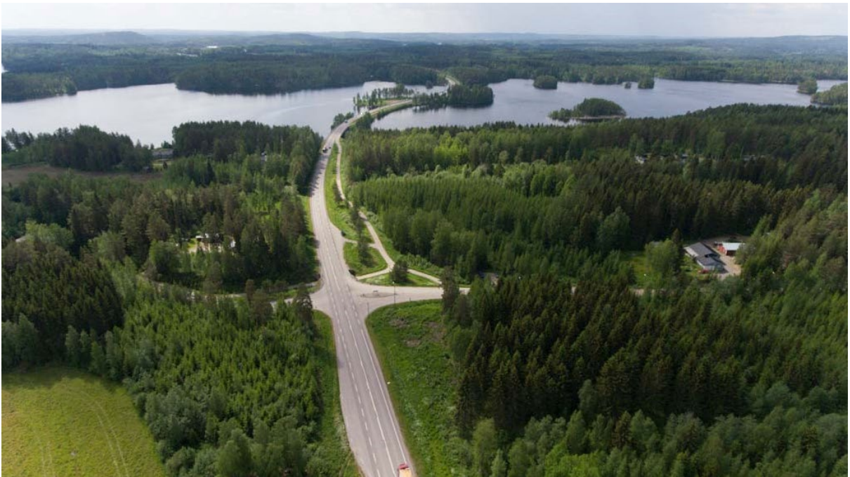
Kuva. Kevätlahdentien, Mämmentien ja valtatie 4 risteys kuvattuna Äänekosken keskustan suuntaan. Risteyksestä alkaa kevyen liikenteen reitti etelän suuntaan. Taustalla näkyy suunnittelualan ulkopuolelle jäävää Ala-Keiteleen vesialuetta.
