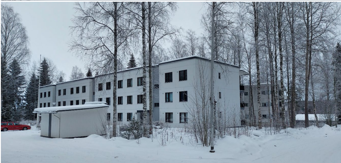
Kuva. Ylhäällä venehalli, keskellä ja alhaalla suunnittelalueen kerrostaloja. Kerrostalot ovat rakentuneet 1970-, 1980- ja 1990-luvuilla ja venehalli on rakennettu 2020-luvulla.
