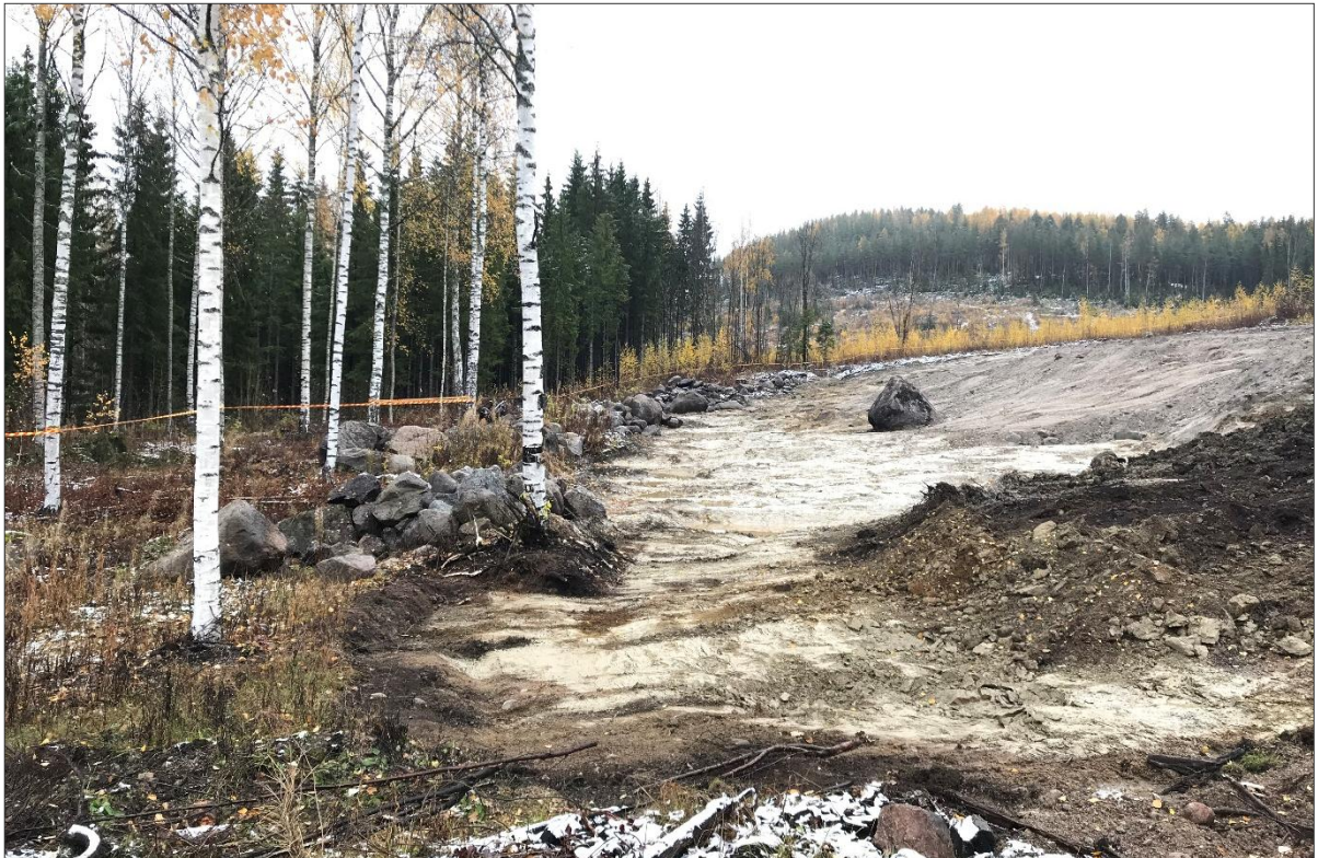
Kuva 5. Kaivualueen pohjoispää kaivettuna perusmaan pintaan saakka. Maa-aineksen seasta eroteltuja kiviä näkyy kaivualueen reunalla. Kuvan oikeassa laidassa näkyy tummempana poistettavaa, pilaantunutta maa-ainesta.
