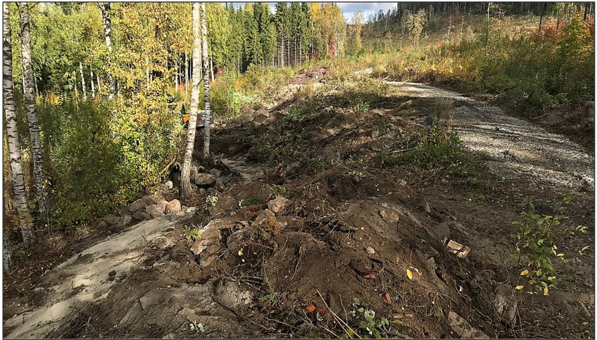
Kuva 2. Alueen 1 kunnostusvaihe, havaittua pilaantunutta maa-ainesta läjitetään aumaksi.
