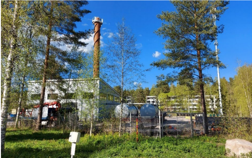
Kuva. Suunnittelualueen ulkopuolella etelässä sijaitseva lämpölaite.
