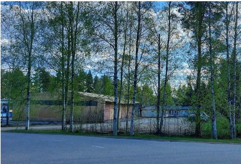
Kuvia. Alueen rakennuskantaa. Alueella on kaksi varistorakennusta/hallia, yksi toimistorakennus sekä varastokatoksia.
