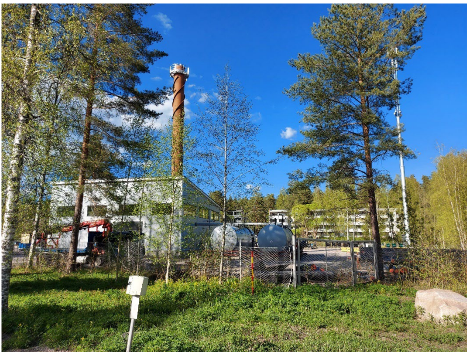
Kuva. Suunnittelualan ulkopuolella etelässä sijaitseva lämpölaitos.
