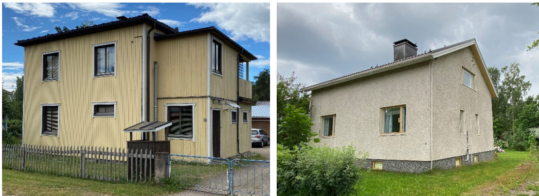
Kuva 7. 1960-luvun rakennuskantaa Koulunmäellä: Pohjantie, Tapionkatu.
