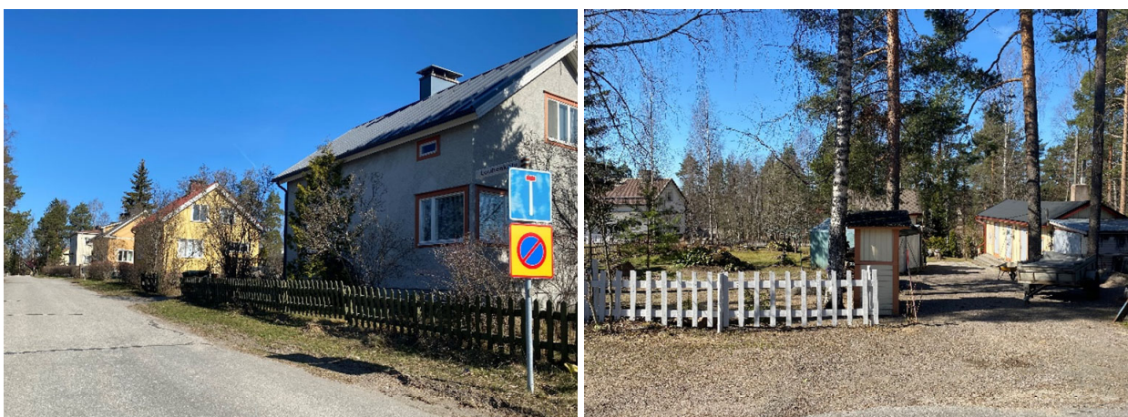
Kuva 14. Louhenkadun varren rakennuskantaa.
