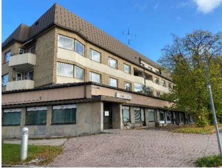
Kuva 17. Vuonna 1959 rakennettu asuin- ja liikerakennus. Katutasossa on useita liiketiloja ja asuintilan sijoittuvat ylempiin kerroksiin. Rakennuksen päädyissä ja kadun puolen julkisivuissa on keltatiiliverhous. Pihan puolen pitkä julkisivu on rapattua pintaa. Kadunpuolen ikkunoiden alaosat on levyverhoillut. Ikkunoissa ei ole erillisiä vuorilautoja. Rakennusta on pidetty kunnossa.
