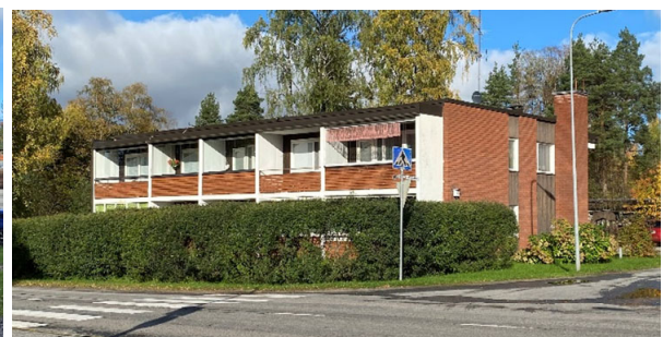
Kuva 19. Ylhäällä vasemmalla vuonna 1971 rakentunut valkotiilinen asuinrakennus. Oikealla vuonna 1973 rakentunut tasakattoinen ja punatiilinen rivitalo. Alhaalla 1970 rakennettu tasakattoinen asuinrakennus. Alaosa betonista ja puoliiksi maan alla. Toinen kerros punatiiliverhouksella. Rakennukset ovat hyväkuntoisia.
