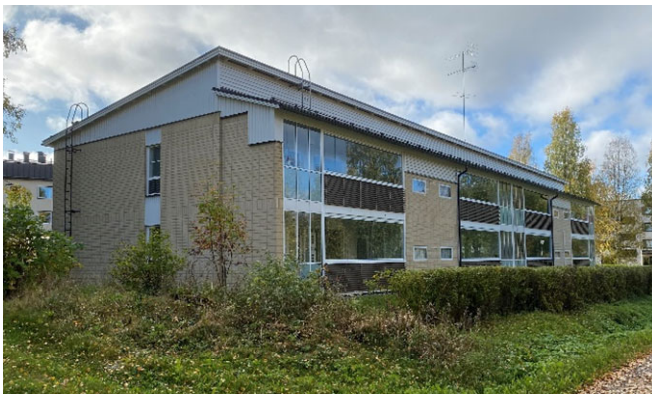
Kuva 22. Kaksikerroksinen rivitalo on rakennettu vuonna 1991. Julkisivussa on keltaista tiiltä ja ruskea laattaa. Sokkeli on ruskea. Rakennus on erittäin hyvässä kunnossa.
