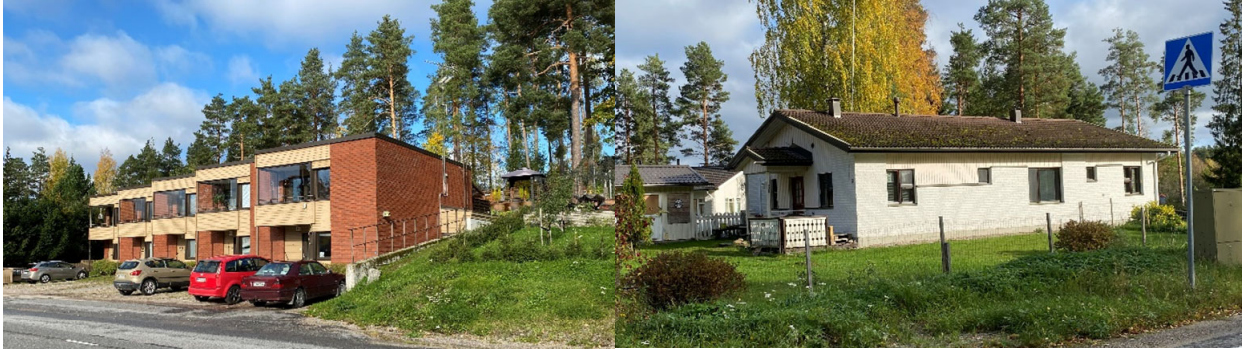
Kuva 20. Vasemmalla vuonna 1981 rakentunut punatiilinen ja tasakattoinen rivitalo. Oikealla vuonna 1989 rakentunut harjakattoinen valkotiilirakennus. Rakennukset ovat hyväkuntoisia.
