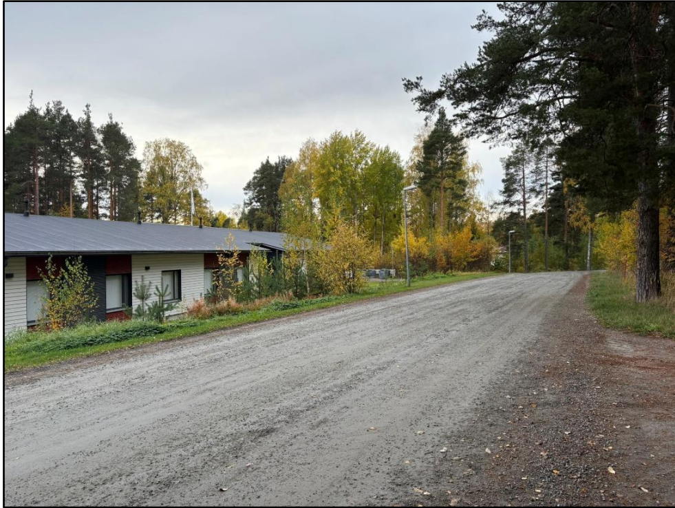
Kuhnamontien rakennettua eteläpuolta kuvattuna länteen.
