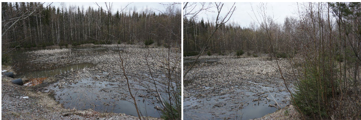
Kuva 6. Hirvaskankaan alueelle rakentunut hulevesiallas.
