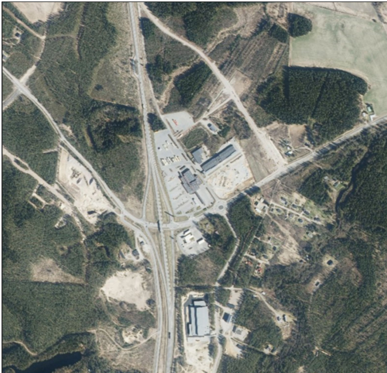
Kuva 1. Ilmakuva Hirvaskankaan alueen rakentunutta rakennuskantaa ja katuverkkoa.
