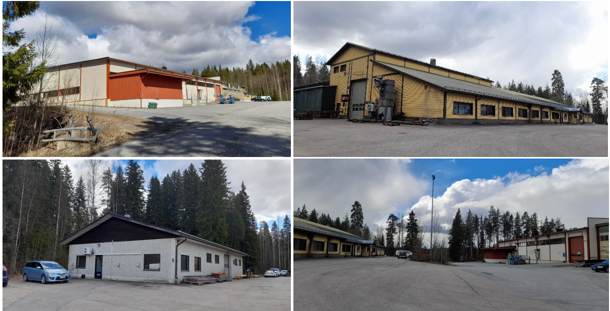
Kuvat 17 - 20. Suunnittelualueen rakennukset. Alueella on nykyisin kolme rakennuskokonaisuutta. Rakennuksia ympäröivä piha-alue kulkuväylineen on pinnoitettua.
