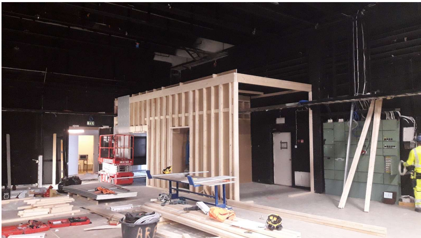
Ison salin levyseinien rakentaminen aloitettu.
