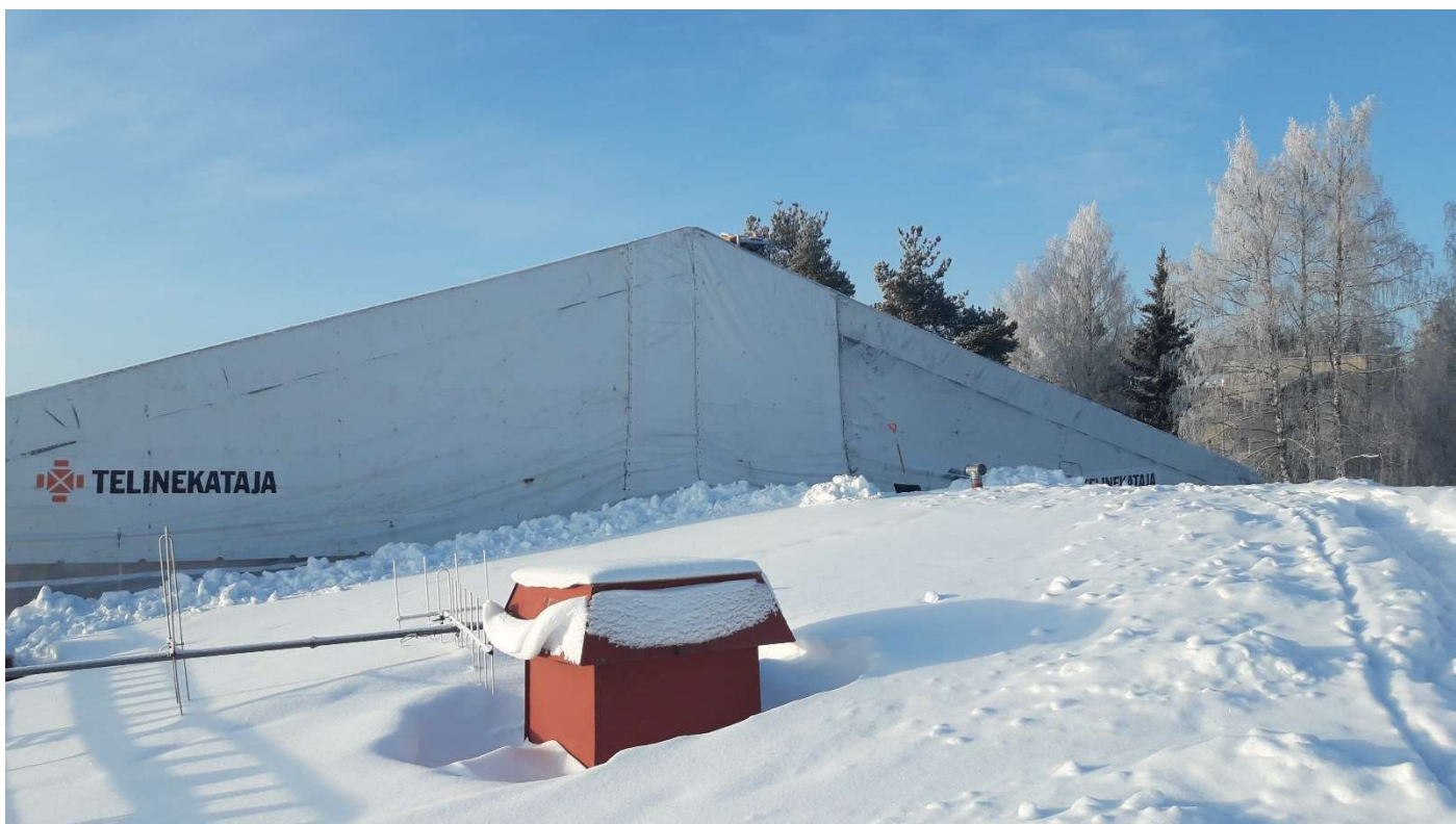
Sääsuoja on valmis, voidaan aloittaa vesikattotyöt.
