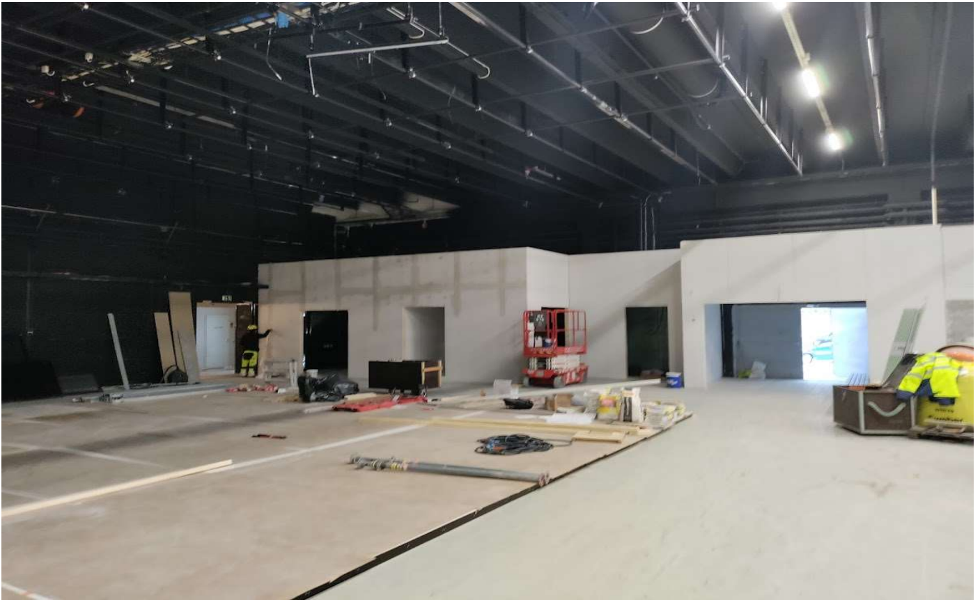
Ison salin levyseinien pohjamaalaukset ja kittaukset on työnalla.
