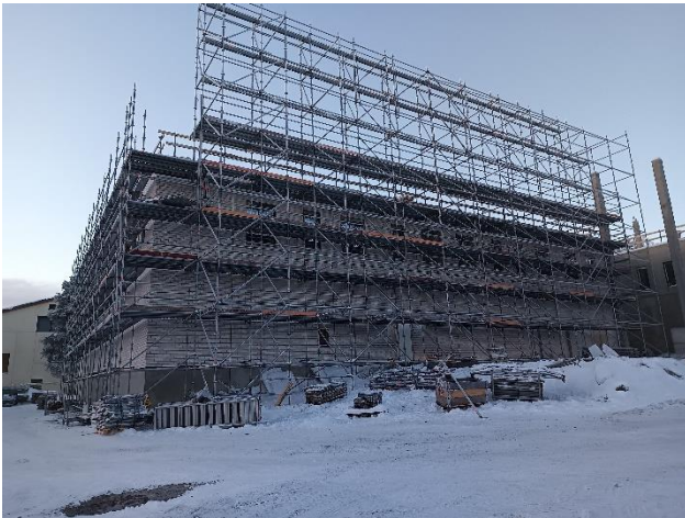
Sääsuojatelineiden asennukset, kaakkoiskulmalta (uimahallin puoli).
