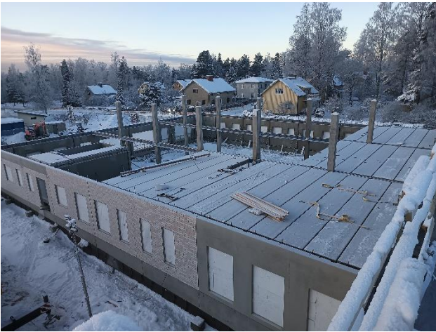
1.krs, lohkon 3 ontelolaatta-asennukset.
