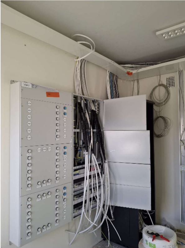
Sähköasennukset jatkuvat työmaalla.
