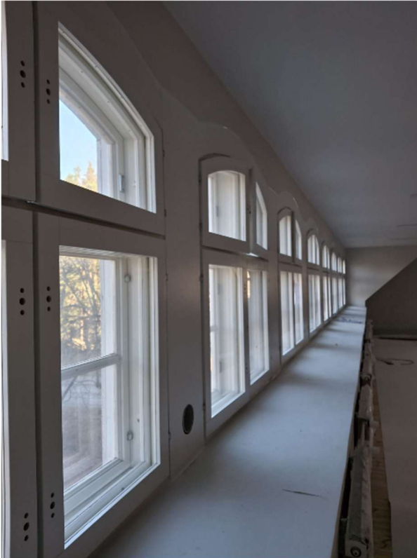
Vanhoja ikkunapuitteita on maalattu.
