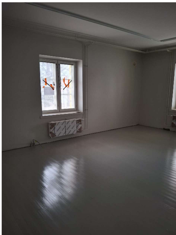
Näyttelytilan lattiamaalaus käynnissä.
