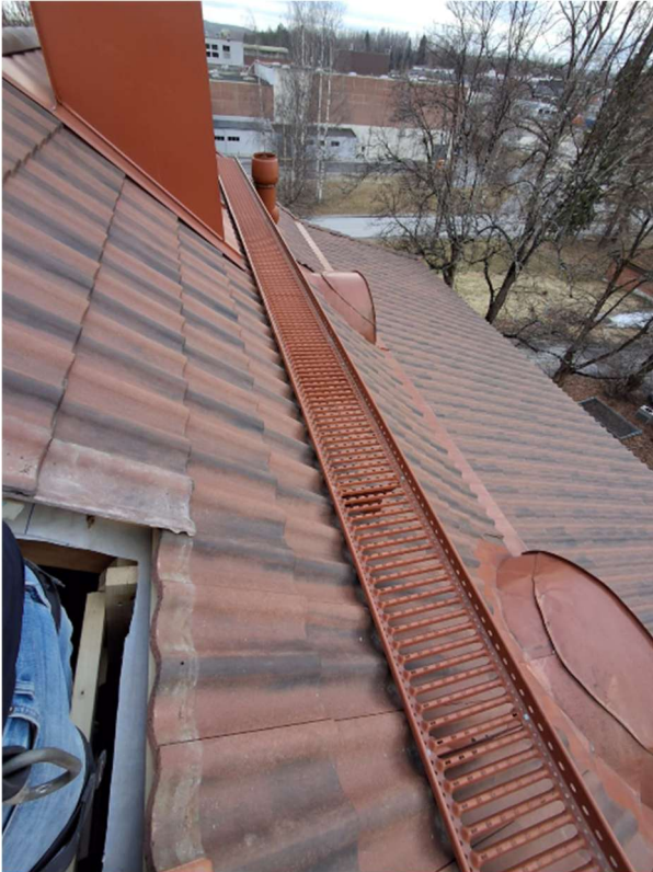
Vesikatolle asennetaan jäähdytyksen ulkoyksiköt. Yksiköt tulevat kulkusillan vierustalle. Kattotyöskentely tehdään turvavaljastyönä.
