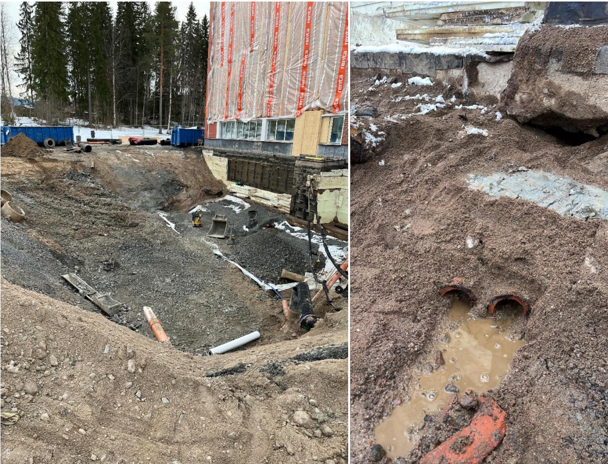
Maatyöt jatkuvat laajennuksen osalta.
