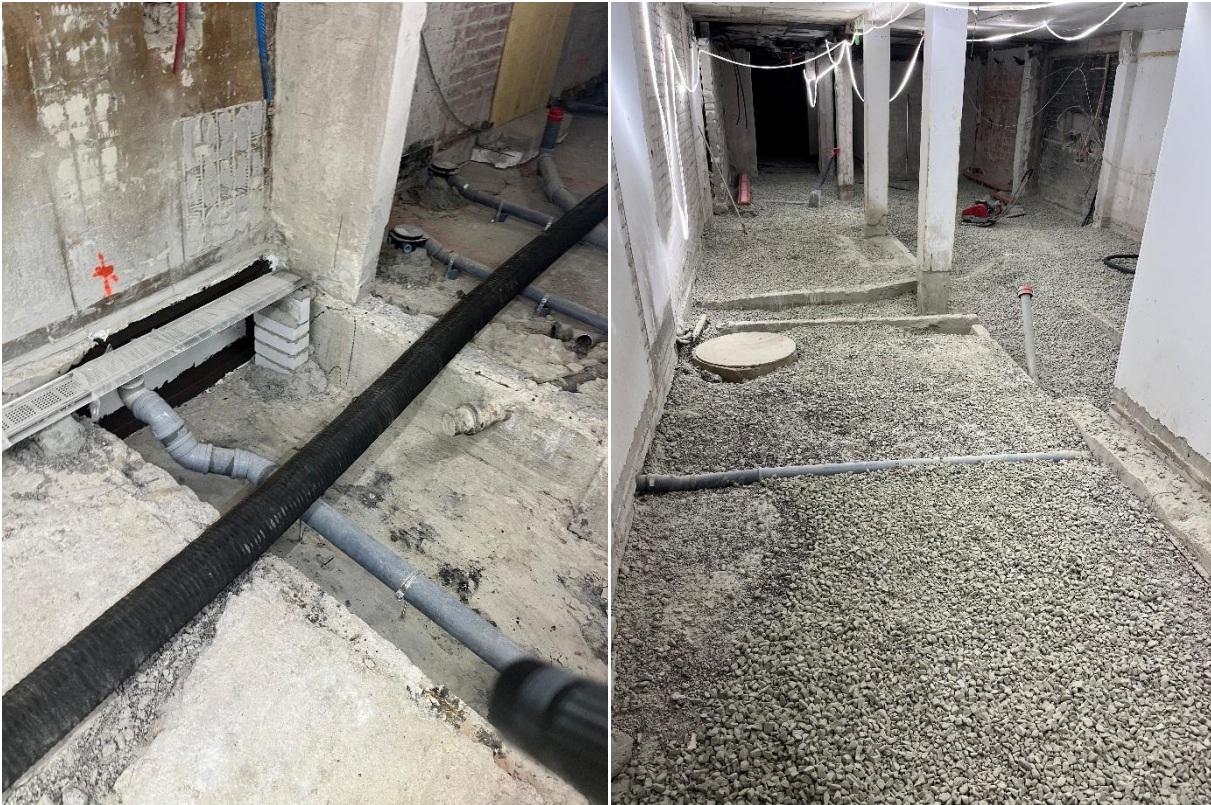
Naisten pesuhuoneessa vanha putkikanaali kapseloitiin umpeen ja tila puhdistettiin, jonka jälkeen puhallettiin vaahtolasimurske.
