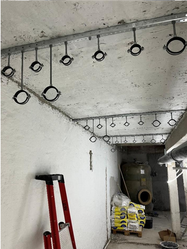
Kellarissa on purettu vanhat tojax-levyt, jonka alta paljastuneet raudoitteet suojattu ja pinnat kapseloitu. Tekniikka-asennuksia jatketaan putkilinjojen asennuksilla.
