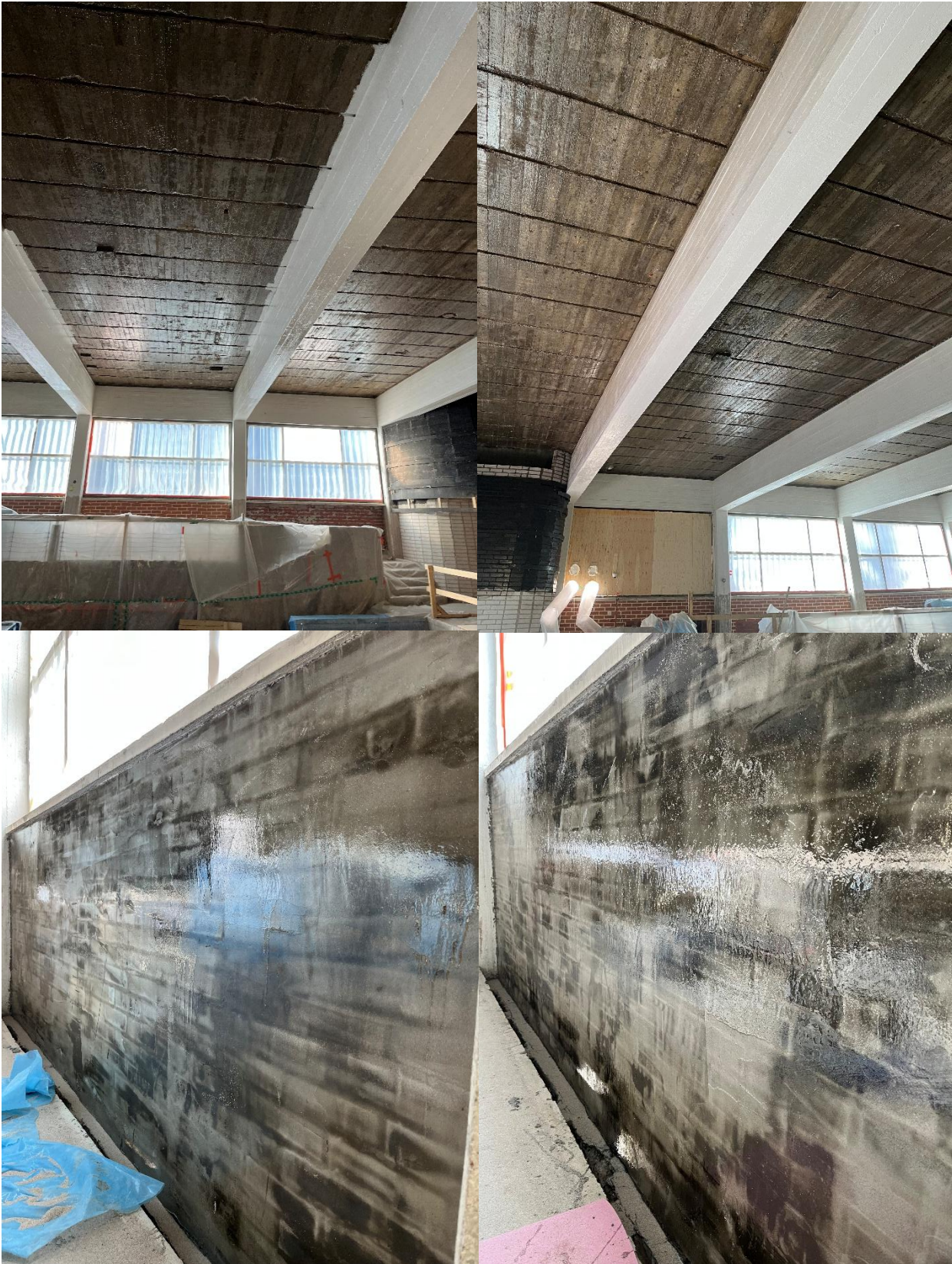
Kattopinta- ja palkit on kapseloitu karbonatisoitumisen estävällä pinnoitteella ja maalattu. Ikkunaseinän tiiliverhous myös kapseloidaan.
