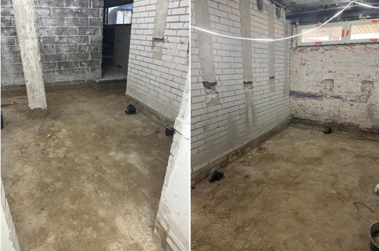
Miesten pesutilasta imetty pintalaatan alta löytynyt täyttöhiekka.
