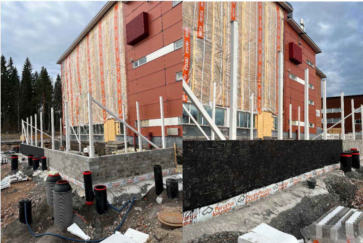
Laajennuksella sokkelit valmiit ja teräsrunko valmistumassa.
