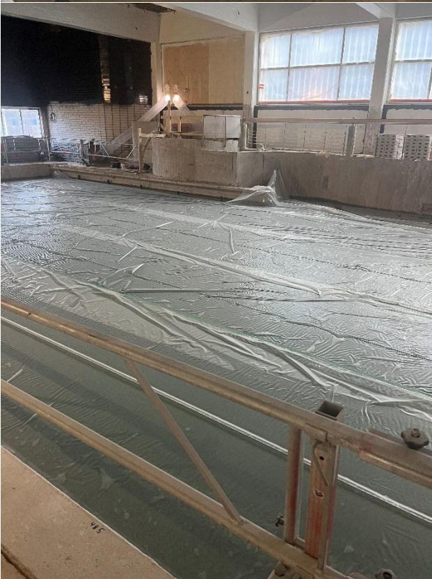
Altaan uudet läpiviennit asennettu, jonka jälkeen allas täytetty vedenpainekeeseen. Allas peitetään kokeen ajaksi haihtumisen minimoimiseksi.
