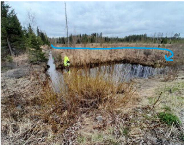
Kuva 12. Laskeutusaltaan kunnostuksen vesien ohjaaminen
