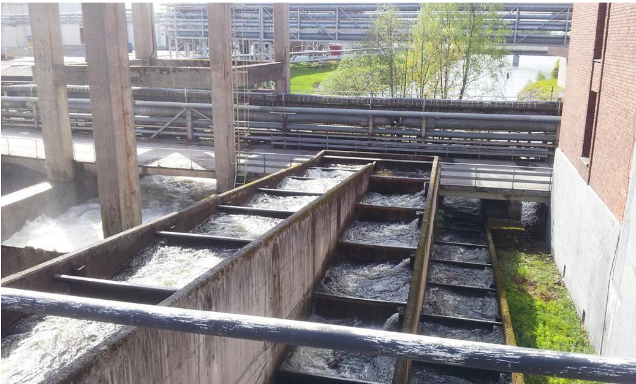
Kuva 2. Vesitetty kalatie ylhäältä kuvattuna. Vasemmalla ohjuksutuskanavan keväiset kuohut (2016).
